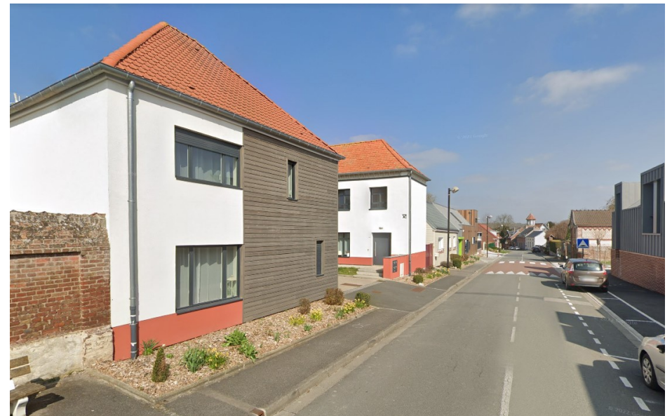
4 logements familiaux (2 neufs et 2 réhabilités)
